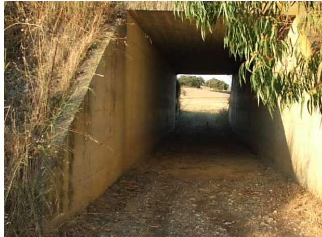
Fig. 17 – Passagem Agrícola ao km 635,980 (nº 3877)
