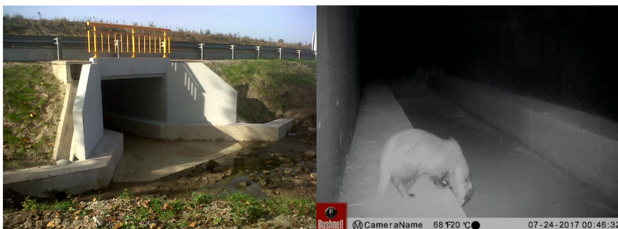
Fig. 21 – PH na EN18, ao km 74,800, com dois passadiços secos. Na fotografia da direita é possível visualizar um texugo a utilizar um dos passadiços (fotografia captada durante a monitorização da PH pela Universidade de Évora ao abrigo do Projeto LIFE LINES).
