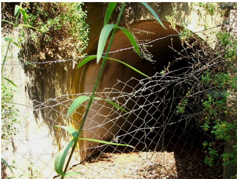
Fig. 15 – Passagem hidráulica nº 3832 junto ao ponto negro 5.
