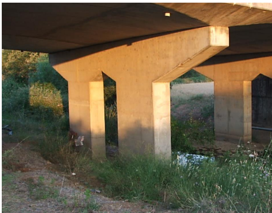
Fig. 16 – Ponte sobre a ribeira de Messejana (nº 3872)
