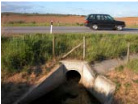
Passagem hidráulica no IP2
