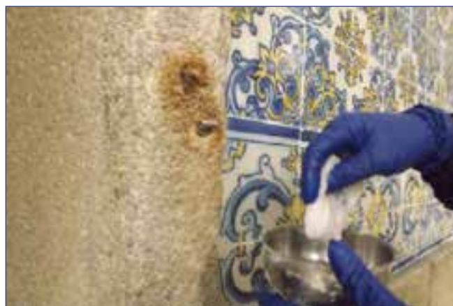
Limpeza e remoção de manchas de oxidação – Agente quelante EDTA
