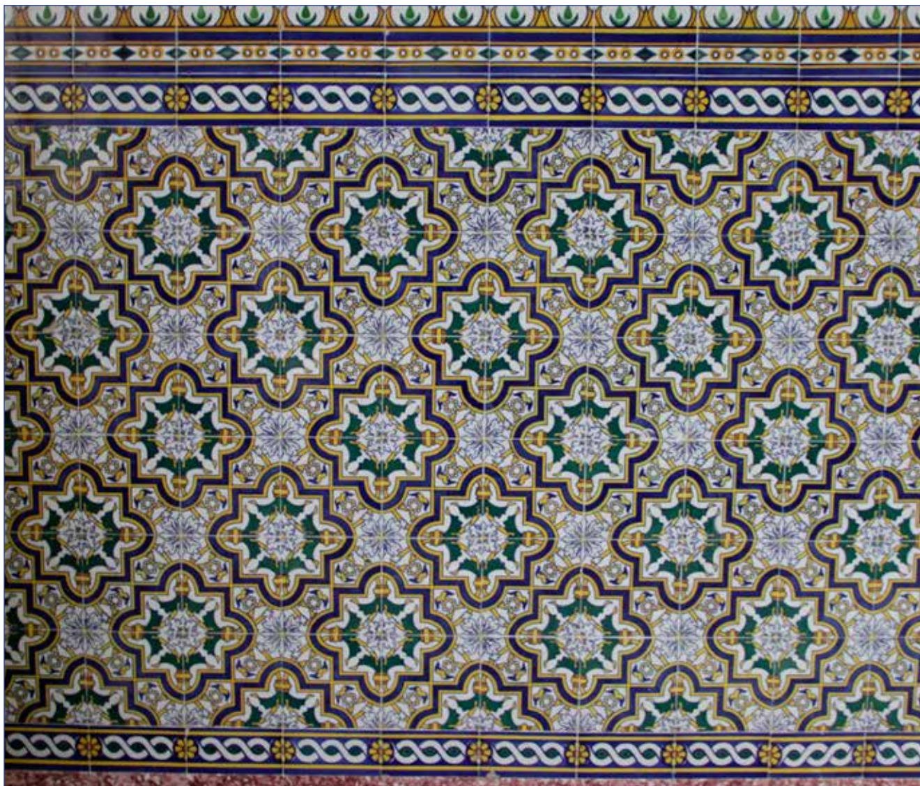
Padrão dos lambris do interior do edifício
