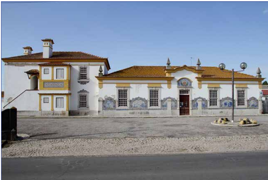
Edifício de passageiros.
