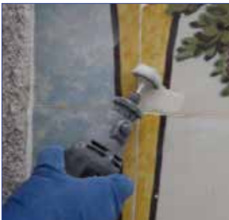
Preenchimento e nivelamento
