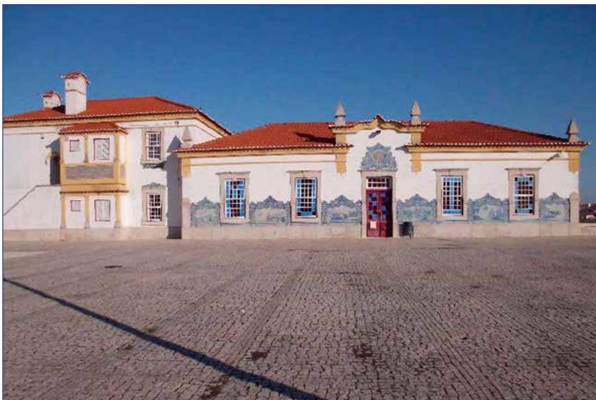
Edifício de passageiros.
