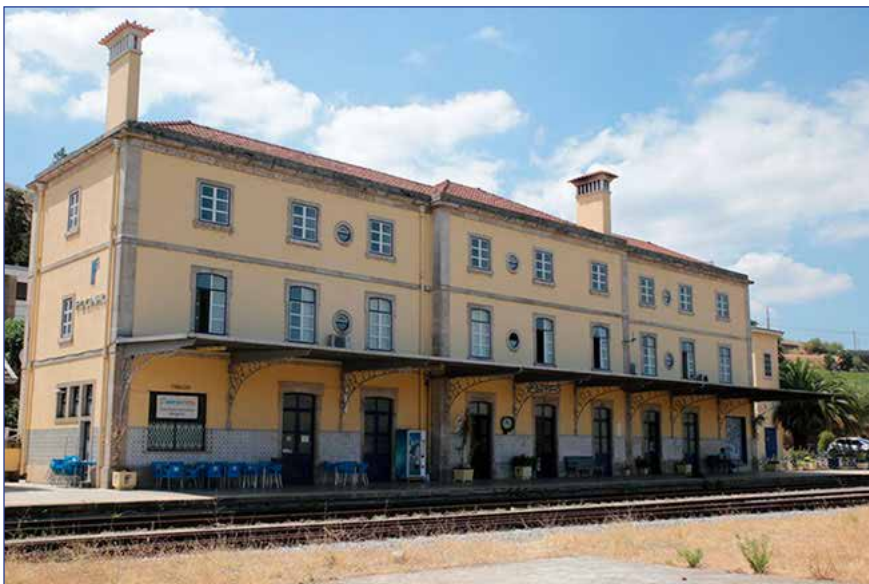
Edifício de passageiros.
