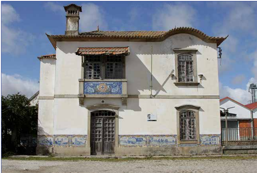
Edifício de passageiros.
