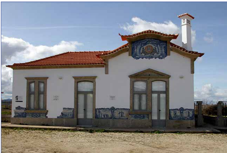
Edifício de passageiros.
