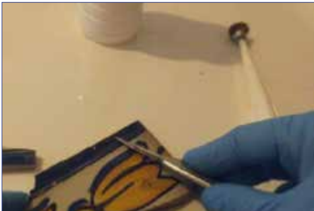
Limpeza – Face nobre – Química e mecânica
