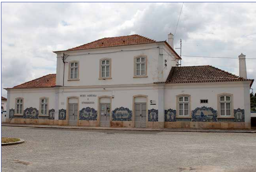
Edifício de passageiros.
