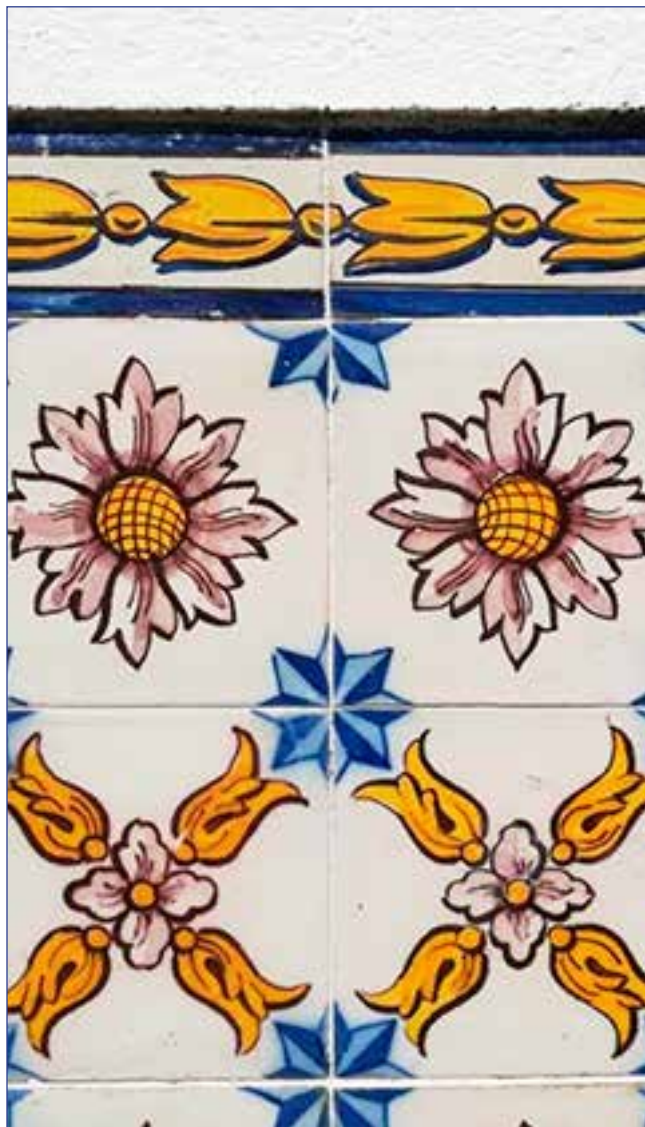
Lambris do edifício das instalações sanitárias
