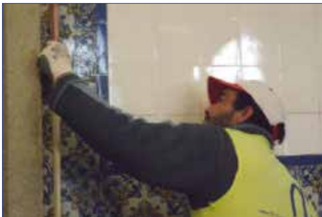
Preenchimento das juntas (argamassa à base de cal) e alinhamento
