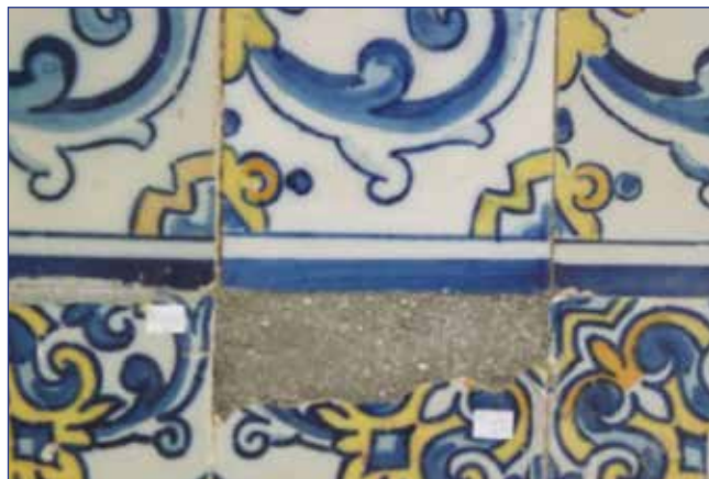
Preenchimento com argamassa do tipo Portland
