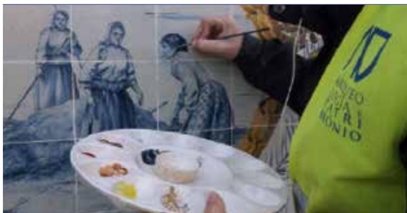
Reintegração cromática a pincel (emulsão de pigmentos puros inorgânicos em resina epóxi – HB Resosurf 816®)
