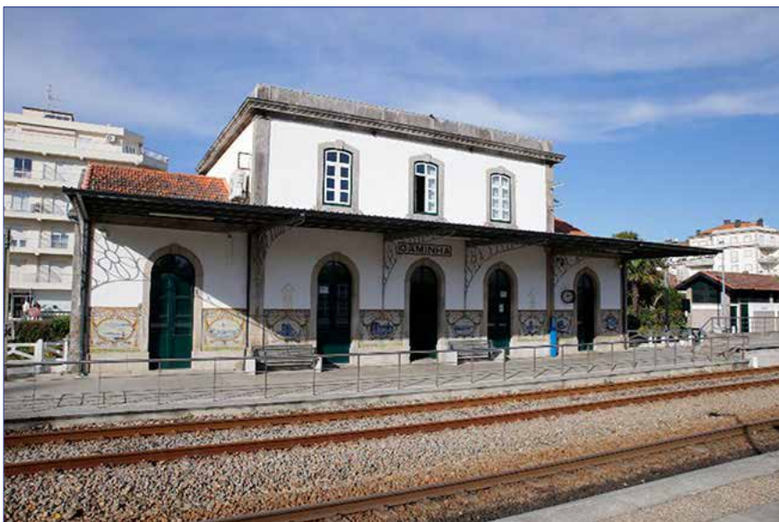
Edifício de passageiros.
