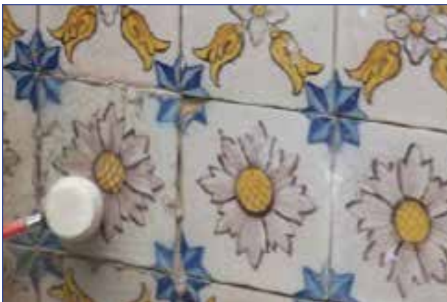
Identificação dos azulejos destacados
