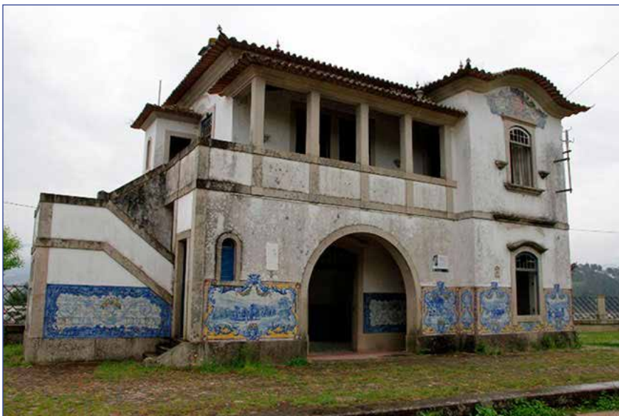
Edifício de passageiros.
