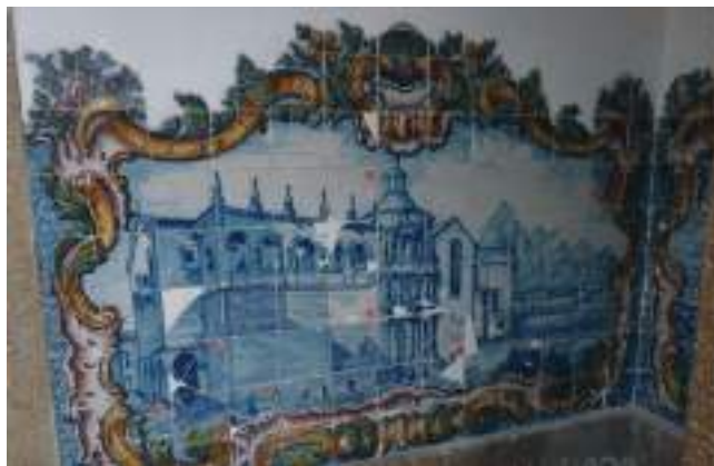
Preenchimento de lacunas – vidro
