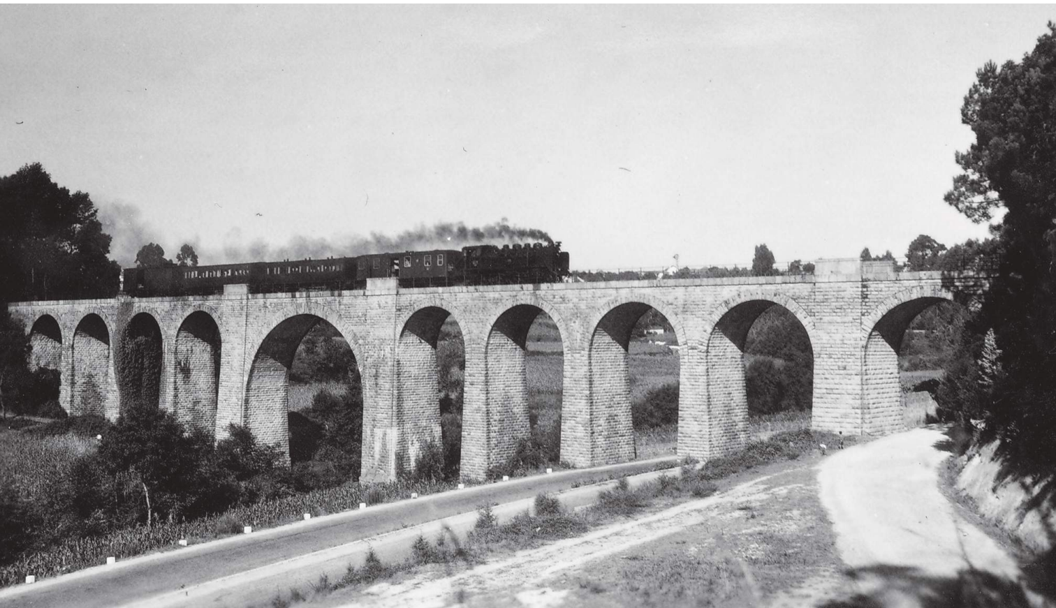
Ponte sobre o rio Leça Câmara Municipal de Matosinhos Acervo Municipal
