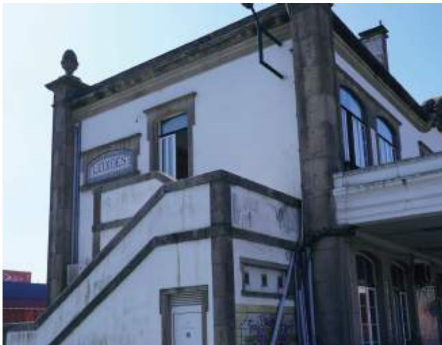
Edifício de Passageiros
