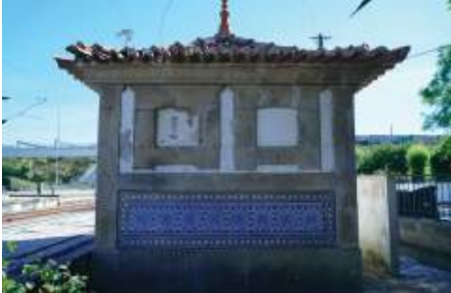
Edifício das instalações sanitárias – Exterior
