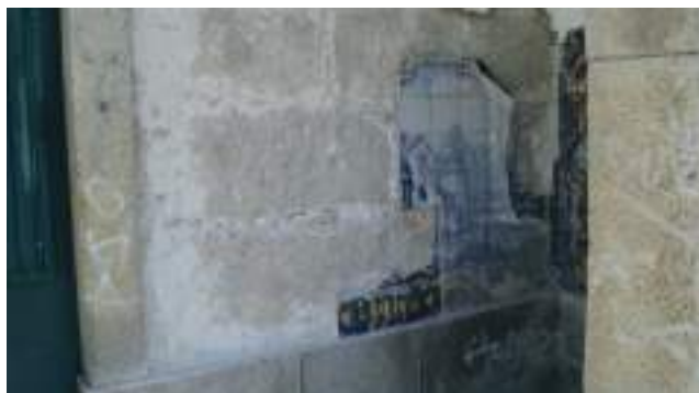
Painel antes da intervenção. (Azulejos removidos e acondicionados pela IP)
