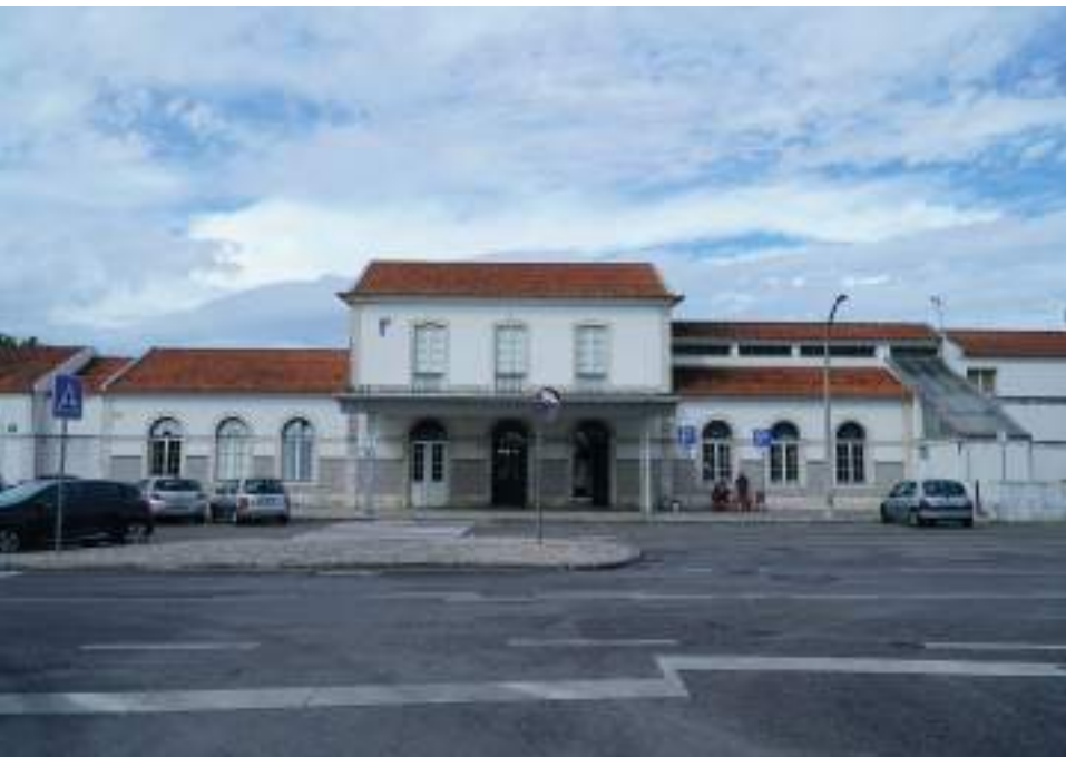
Edifício de Passageiros
