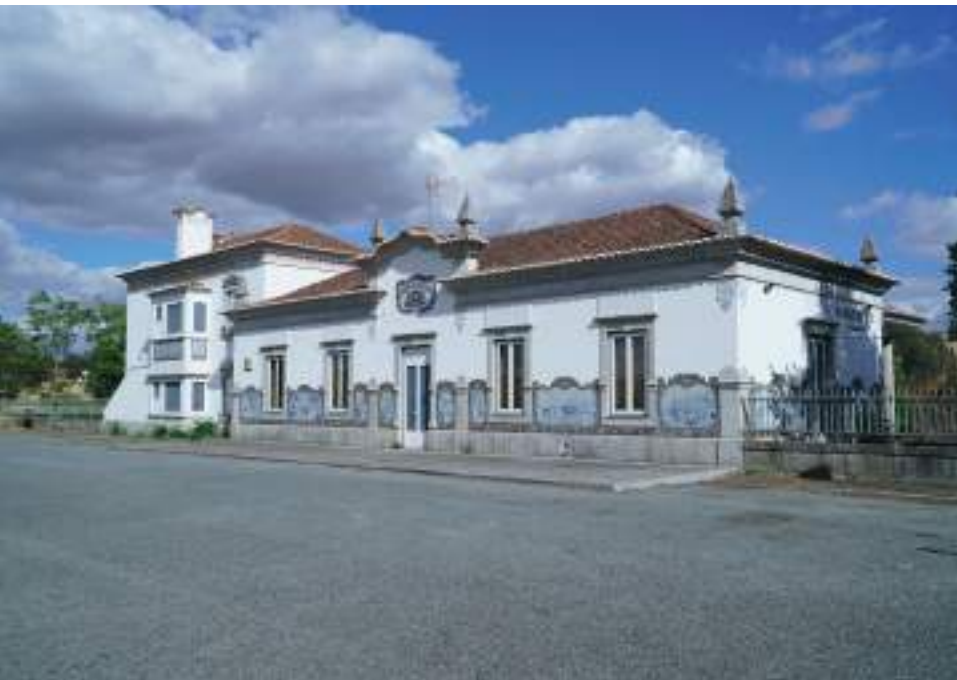
Edifício de Passageiros
