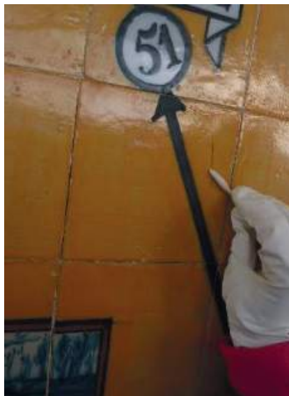
Estação de Leiria Limpeza da superfície: remoção de pingos de tinta
