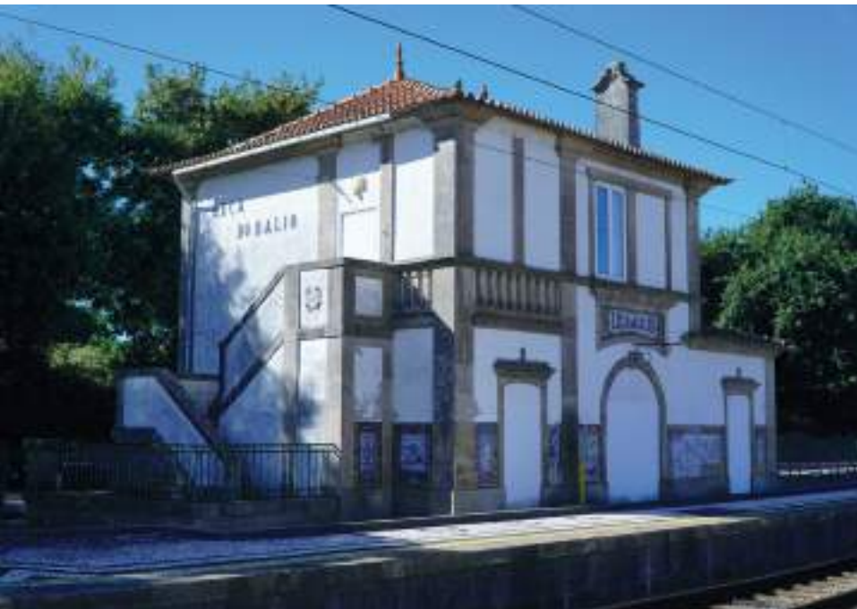
Edifício de Passageiros
