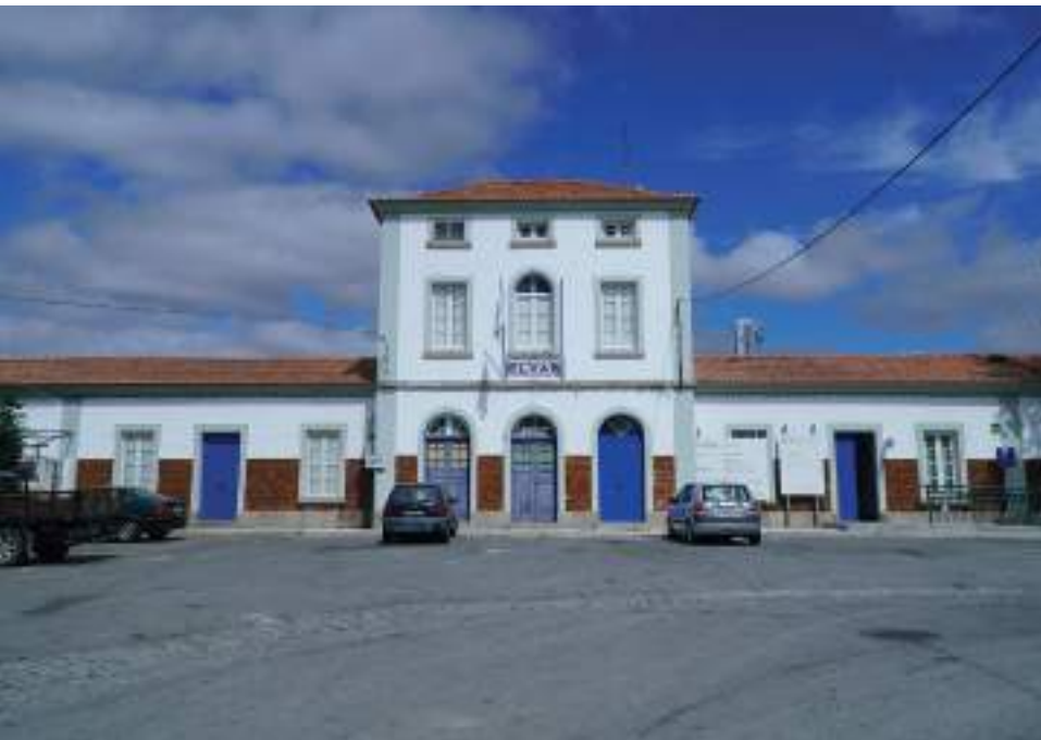
Edifício de Passageiros
