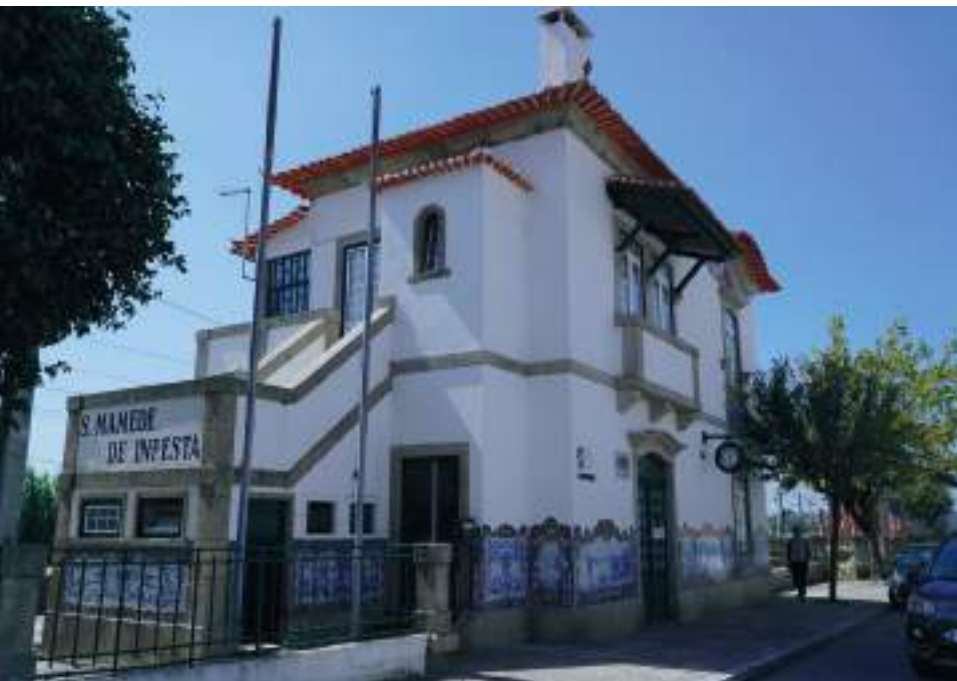
Edifício de Passageiros
