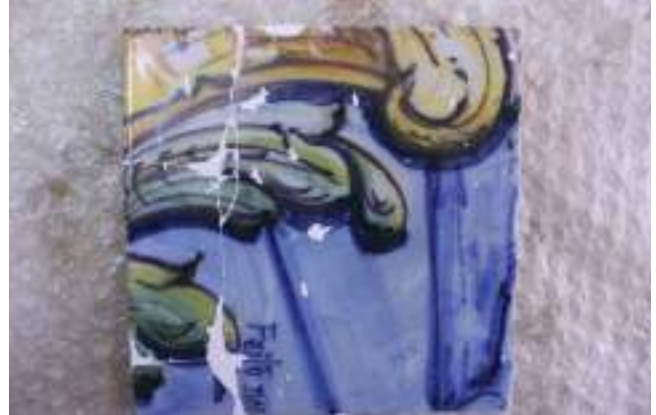
Preenchimento de lacunas - vidro
