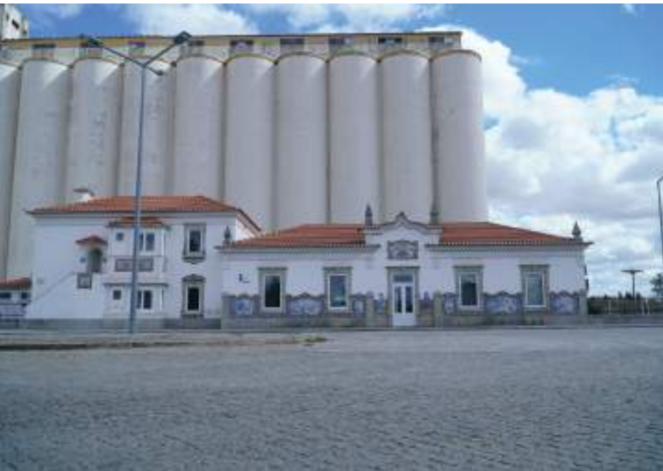
Edifício de Passageiros
