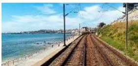
A intervenção foi consignada, no dia 6 de dezembro pelo valor de 31,6 milhões de euros, e contempla a migração do atual sistema de eletrificação de 1,5 kV em corrente contínua para 25 kV em corrente alternada, com a substituição integral da catenária existente entre as Estações de Cais do Sodré (inclusive) e Cascais (exclusive).
