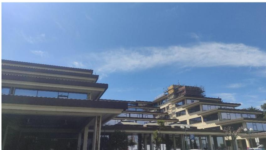
Ainda no âmbito das empreitadas de renovação de edifícios do campus do pragal, destacam-se também as intervenções de isolamento térmico da envolvente opaca das fachadas dos edifícios, onde este isolamento está a ser reforçado pelo exterior, através da colocação de painéis de isolamento em lã mineral.
