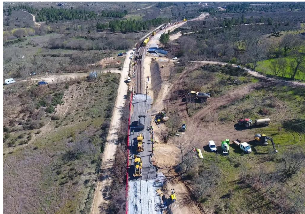
Tratamento de Plataforma na Variante 2
