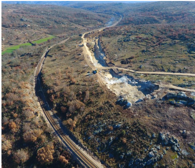
Escavação com recurso a explosivos na Variante 5
