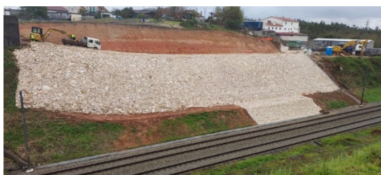
Linha do Norte – Estabilização do talude ao Pk 196,300
