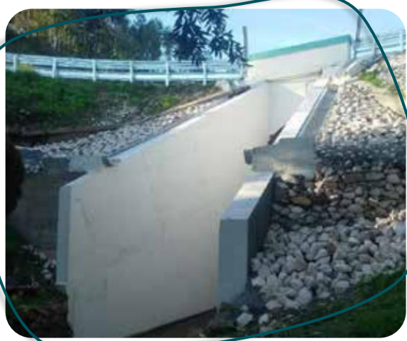
Limpeza, conservação, reconstrução e construção de órgãos de drenagem
