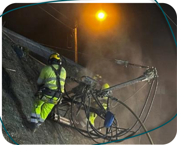
Estabilização, proteção e reperfilamento de taludes
