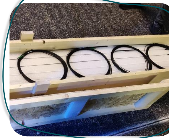
Instalação de sensores de movimento ou monitorização com tecnologia InSAR
