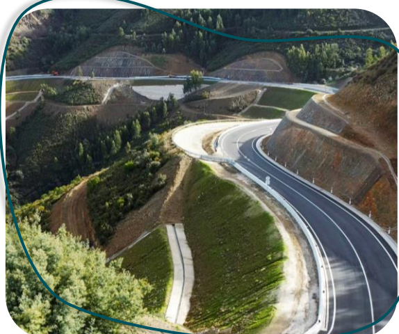
Manutenção e estabilização de taludes
