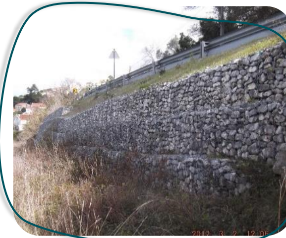
Obras de contenção
