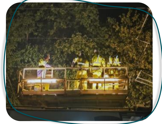
Execução de Trabalhos de Gestão de Vegetação
