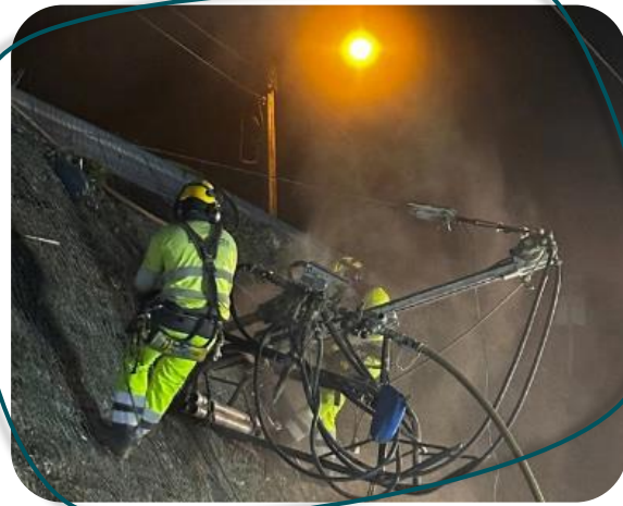
Estabilização, proteção e reperfilamento de taludes
