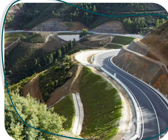
Manutenção e estabilização de taludes
