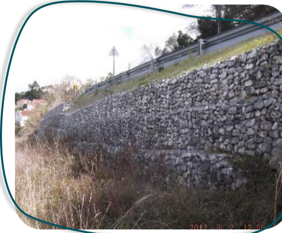
Obras de contenção
