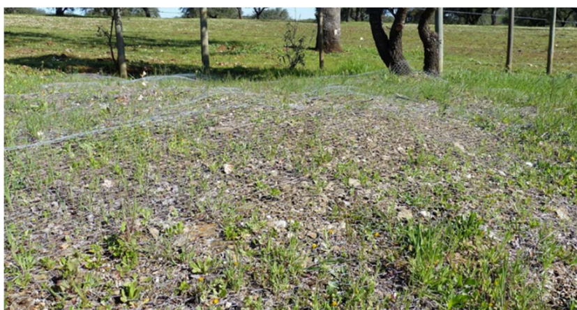
Fig. 34 – Colocação de rede sobre os taludes da EN4, com o objetivo de impedir a sua colonização por coelhos.
