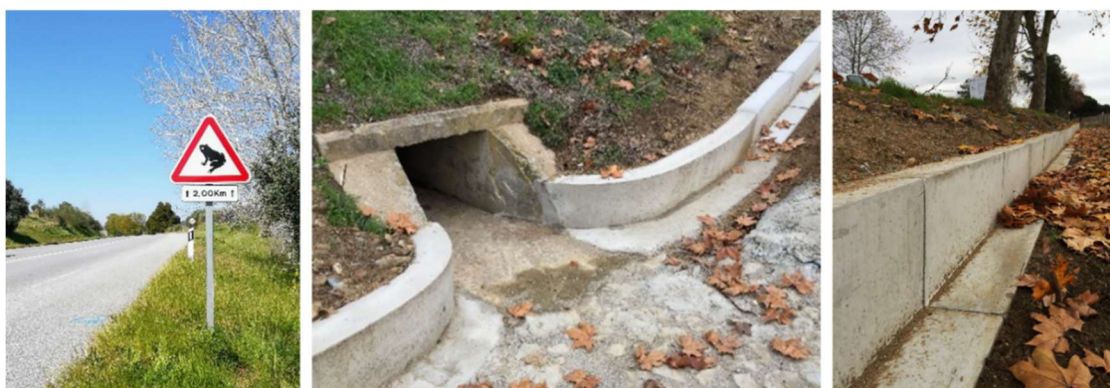
Fig. 33 – Sinalização vertical específica para anfíbios, criada no âmbito do Projeto LIFE LINES (à esquerda) e barreiras de encaminhamento de anfíbios para PH (ao centro e à direita).
