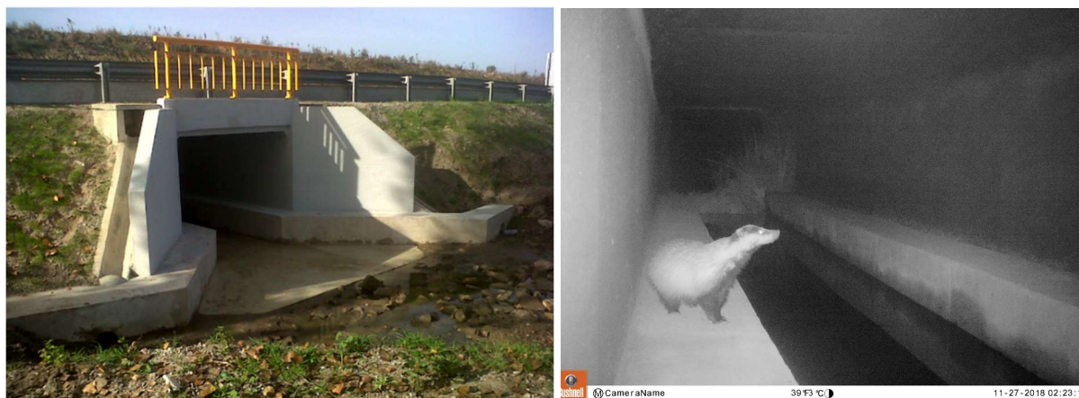
Fig. 36 – PH na EN18, ao km 274,800, com dois passadiços secos. Na fotografia da direita é possível visualizar um texugo a utilizar um dos passadiços (fotografia captada pela Universidade de Évora durante a monitorização da PH).
