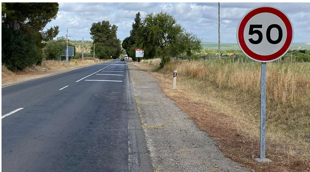
Fig. 31 – Sinalização de limite de velocidade na EN260, com bandas cromáticas e painel com sinalização de alerta relativa ao lince-ibérico (ao fundo).
