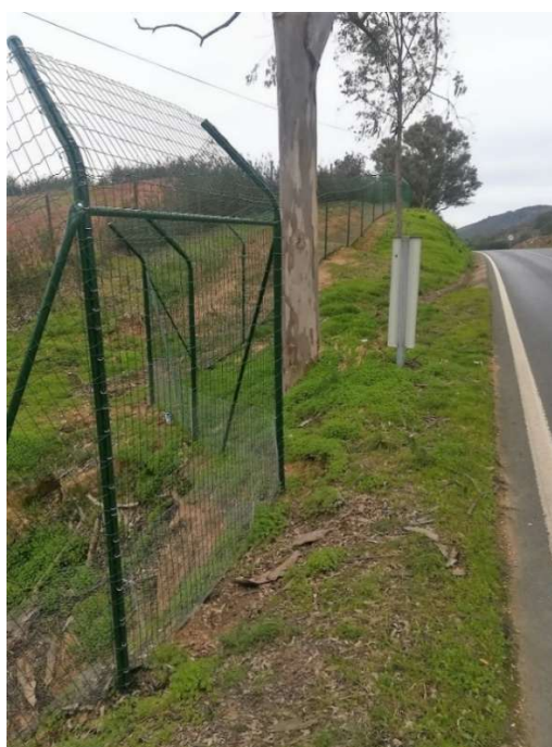
Fig. 30 – Vedação para lince-ibérico, instalada na EN122.
