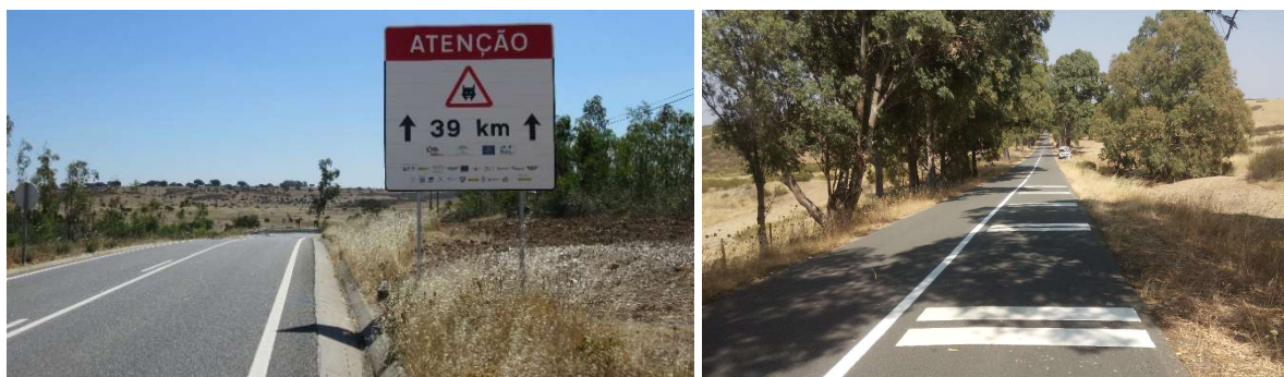
Fig. 27 – Sinalização avisadora de perigo, específica do lince-ibérico (esquerda) e bandas cromáticas redutoras de velocidade (direita) instaladas na EN122.
