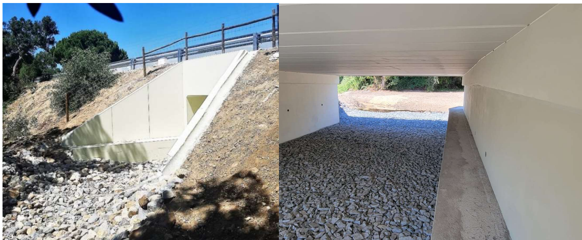
Fig. 24 – Passadiços de fauna implementados no IC1 aos km 548,2 (esquerda) e 583,5 (direita).
