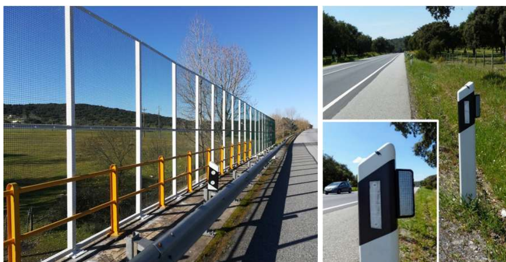
Fig. 35 – Barreiras para elevar e encaminhar o voo de corujas (à esquerda) e refletores específicos para refletir a luz dos faróis para a envolvente da via e alertar os animais de forma mais eficiente (à direita).
