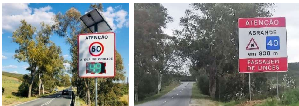
Fig. 29 – Painéis eletrónicos para controlo de velocidade na EN122 e painéis com sinalização do lince-ibérico e recomendação de limite de velocidade na ER267.
