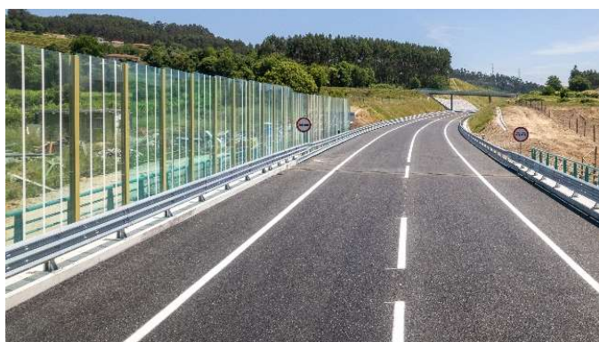
Fig. 26– Colocação de faixas verticais em barreiras acústicas transparentes, no IC35, para aumentar a sua visibilidade para as aves e evitar a mortalidade por colisão com as mesmas.
