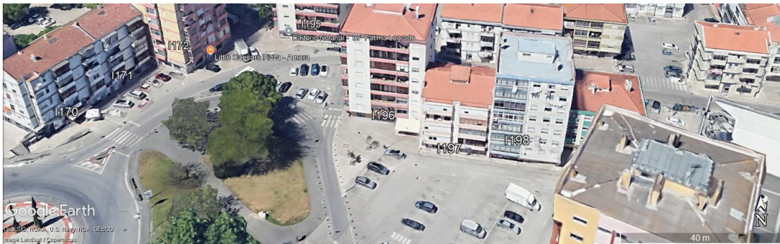
Figura 16: Imagem aérea dos Recetores I170 a I172 e I195 a I198.
