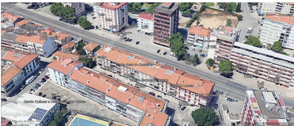
Figura 14: Imagem aérea dos Recetores I154 a I169 e I174 a I188.
