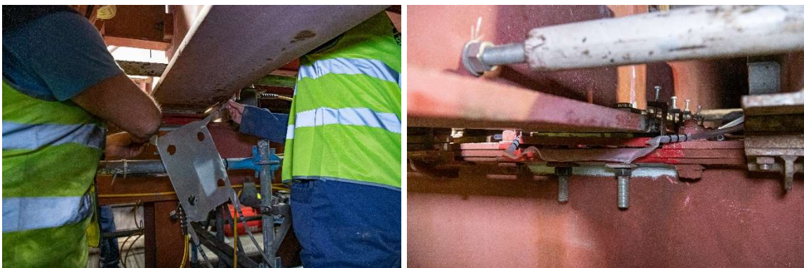
Figura 10. Colocação dos sacos dos calços líquidos.
