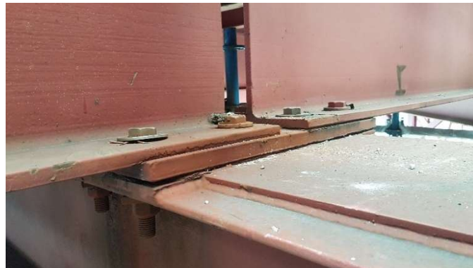
Figura 1. Exemplo dos apoios originais das extremidades de 2 longarinas consecutivas.
