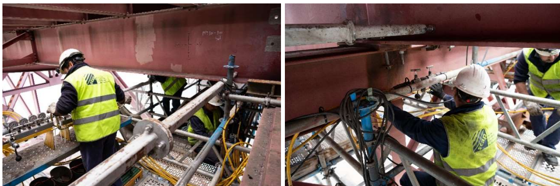
Figura 4. Montagem dos circuitos hidráulicos para a elevação das longarinas.
