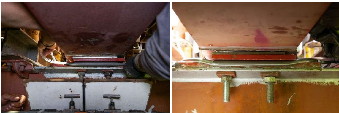
Figura 13. Calços líquidos durante a após a injeção.
