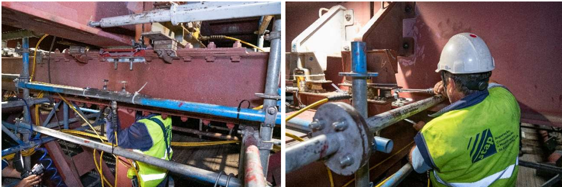
Figura 11. Aperto dos parafusos no interior da carlinga e dos parafusos exteriores.
