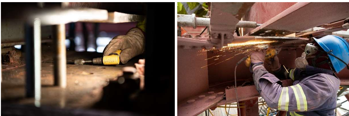
Figura 6. Preparação das superfícies para colocação dos novos apoios.
