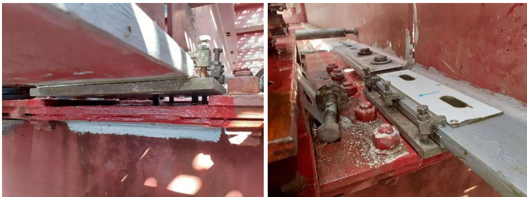
Figura 8. Instalação das chapas finas de inox polido dos novos apoios das longarinas.
