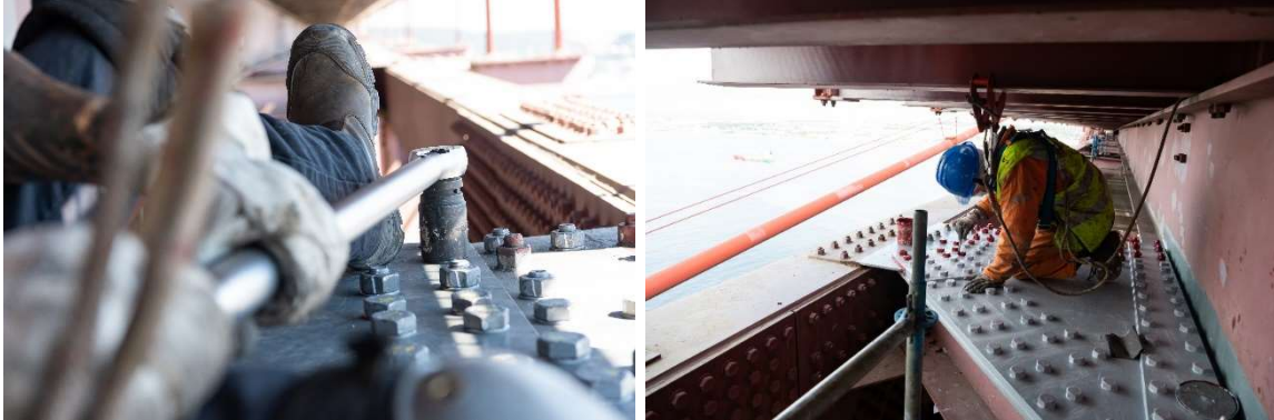
Figura 18. Aperto dos parafusos pré-esforçados. Aplicação da protecção anticorrosiva para finalização dos trabalhos de reforço nos apoios de continuidade das longarinas.
