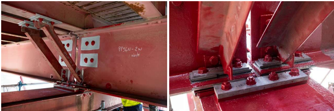
Figura 14. Novos apoios de 2 longarinas consecutivas após finalização dos trabalhos.
