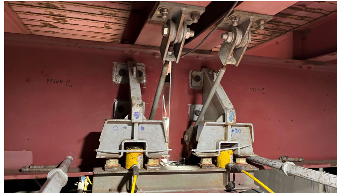
Figura 3. Exemplo da instalação do travamento lateral e da ferramenta de elevação em 2 longarinas consecutivas.
