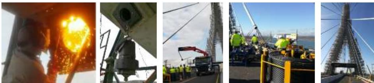
Figura 18. Sequência na colocação de novas ancoragens, novos cordões e tensionamento
