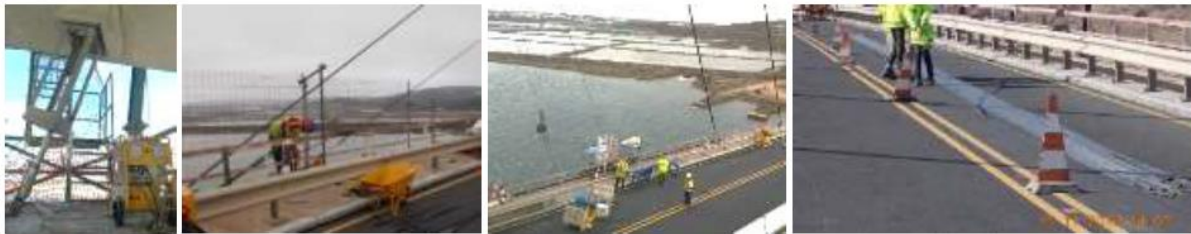
Figura 16. Cadeira e macaco monocordão na ancoragem inferior e remoção de cordões
