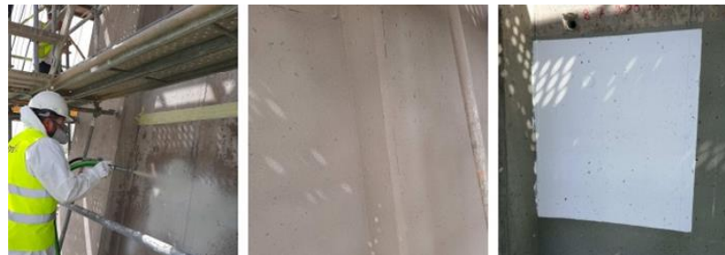
Figura 21. Trabalhos de proteção das superfícies de betão
