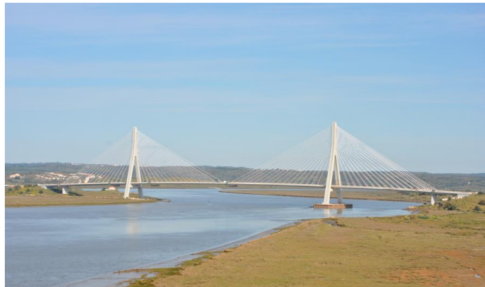
Figura 1. Vista geral da Ponte Internacional sobre o Rio Guadiana
