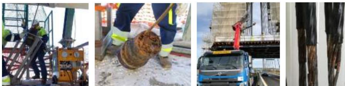
Figura 17. Sequência de remoção ancoragens e amostra de cordões removidos
