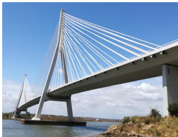
Figura 22. Aspeto final da obra
