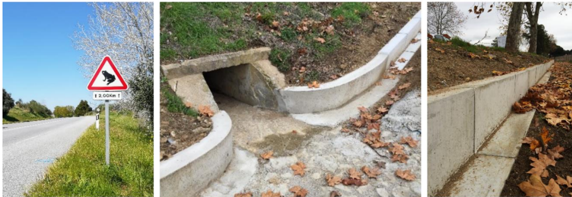
Fig. 30 – Sinalização vertical específica para anfíbios, criada no âmbito do Projeto LIFE LINES (à esquerda) e barreiras de encaminhamento de anfíbios para PH (ao centro e à direita).
