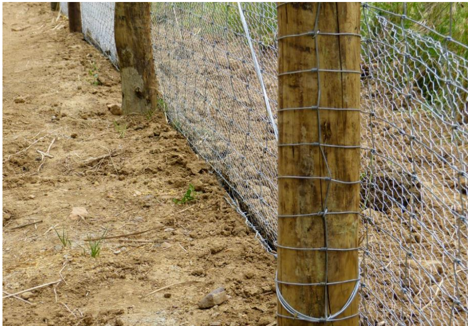
Fig. 25 – Rede adicional, de malha apertada acoplada à vedação principal, disposta em “L”, com uma base de 50 cm enterrada.
