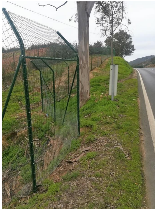
Fig. 29 – Vedação instalada na EN122.
