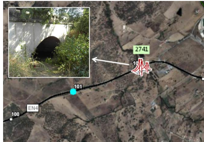
Fig. 19 – Troço da EN4 com maior densidade de javalis atropelados (assinalado a azul), com representação da passagem existente sob a estrada (com referência ao número da obra de arte) e respetiva imagem.
