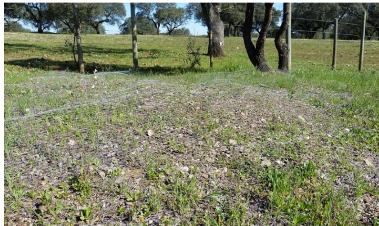
Fig. 31 – Colocação de rede sobre os taludes da EN4, com o objetivo de impedir a sua colonização por coelhos.
