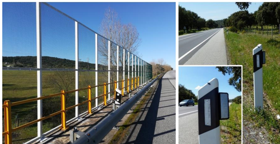
Fig. 32 – Barreiras para elevar e encaminhar o voo de corujas (à esquerda) e refletores específicos para refletir a luz dos faróis para a envolvente da via e alertar os animais de forma mais eficiente (à direita).
